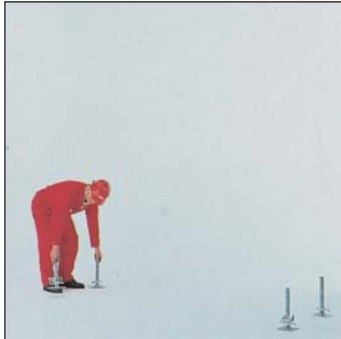
Gewindefußplatten aufstellen
