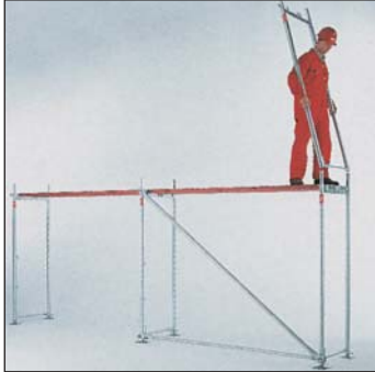
Vertikalrahmen der nächsten Lage(n) aufstecken
