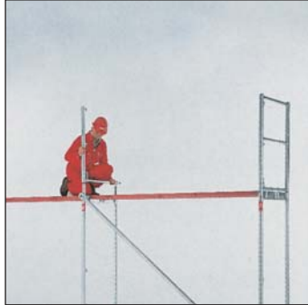
Geländerpfostenstützen aufstecken
